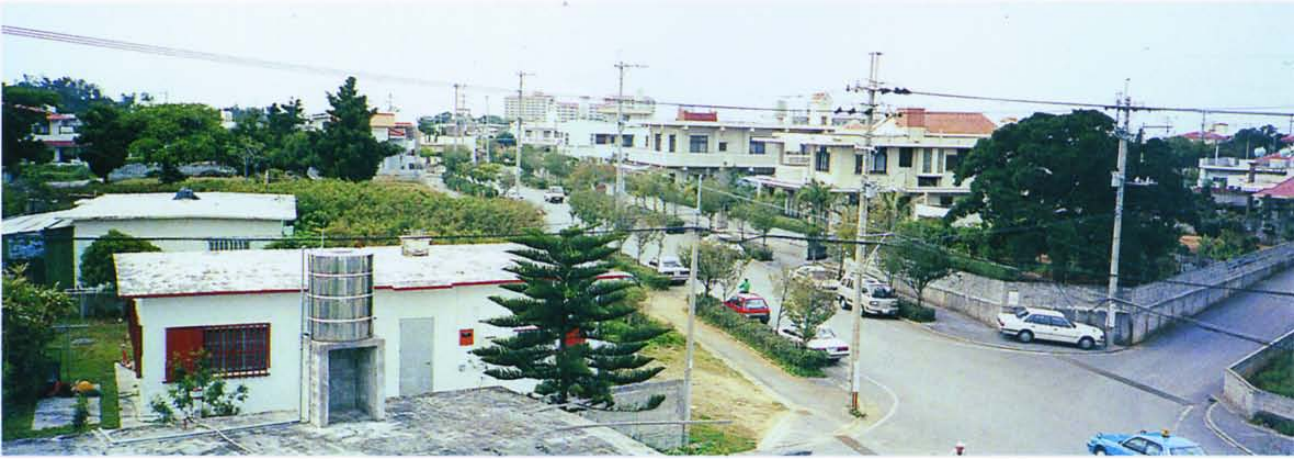
533 古堅はかつてはモーガンマナー地域に集落はあったが、戦後の基地接収で現在の古堅南小学校の東側と大湾西部に集落を形成してきた。終戦後は米人向けの貸住宅が多く建った。嘉手納航空隊の家庭部隊跡地が1977年（昭和52）11月30日に返還され、以後1980年（昭和55）12月より区画整理事業を行い8年の歳月をかけて1990年（平成2）1月完了した。同地にはNTT沖縄支店嘉手納営業所・村営古堅団地がある。
