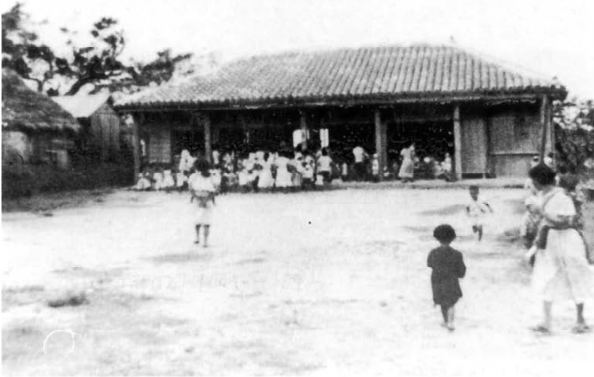
457 瓦葺の頃の高志保公民館。
