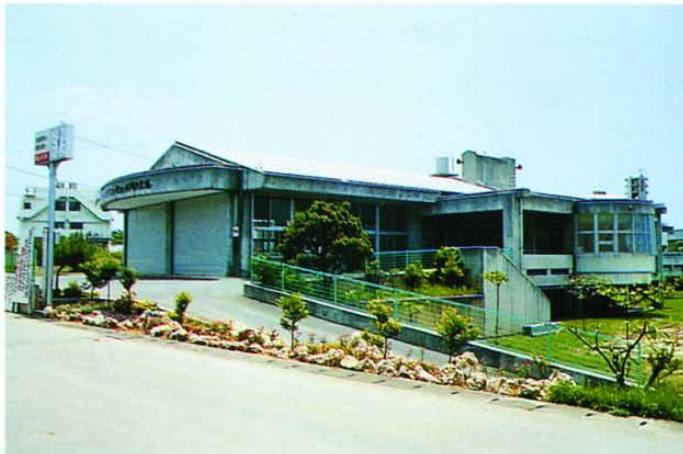
517 渡具知公民館。 1990年（平成2）7月竣工。
