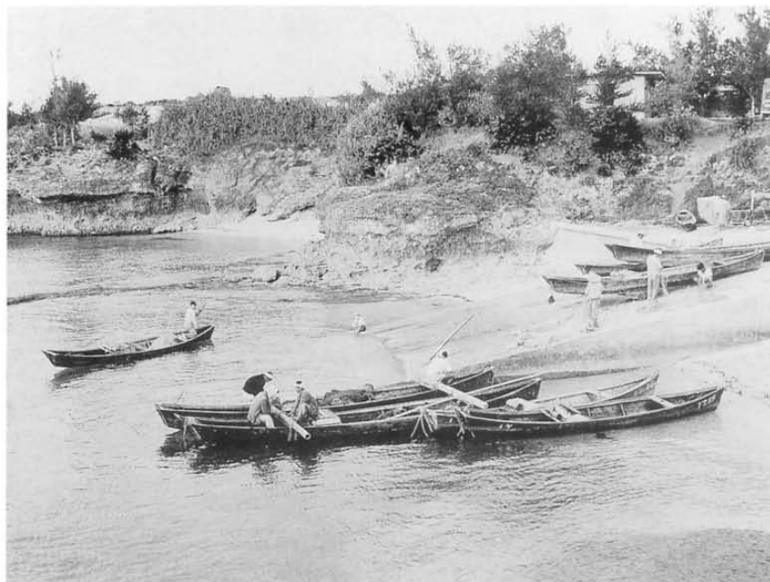
347 都屋漁港の浚渫工事は1952年度政府補助事業で、船揚場の新設は1963年事業であった。
