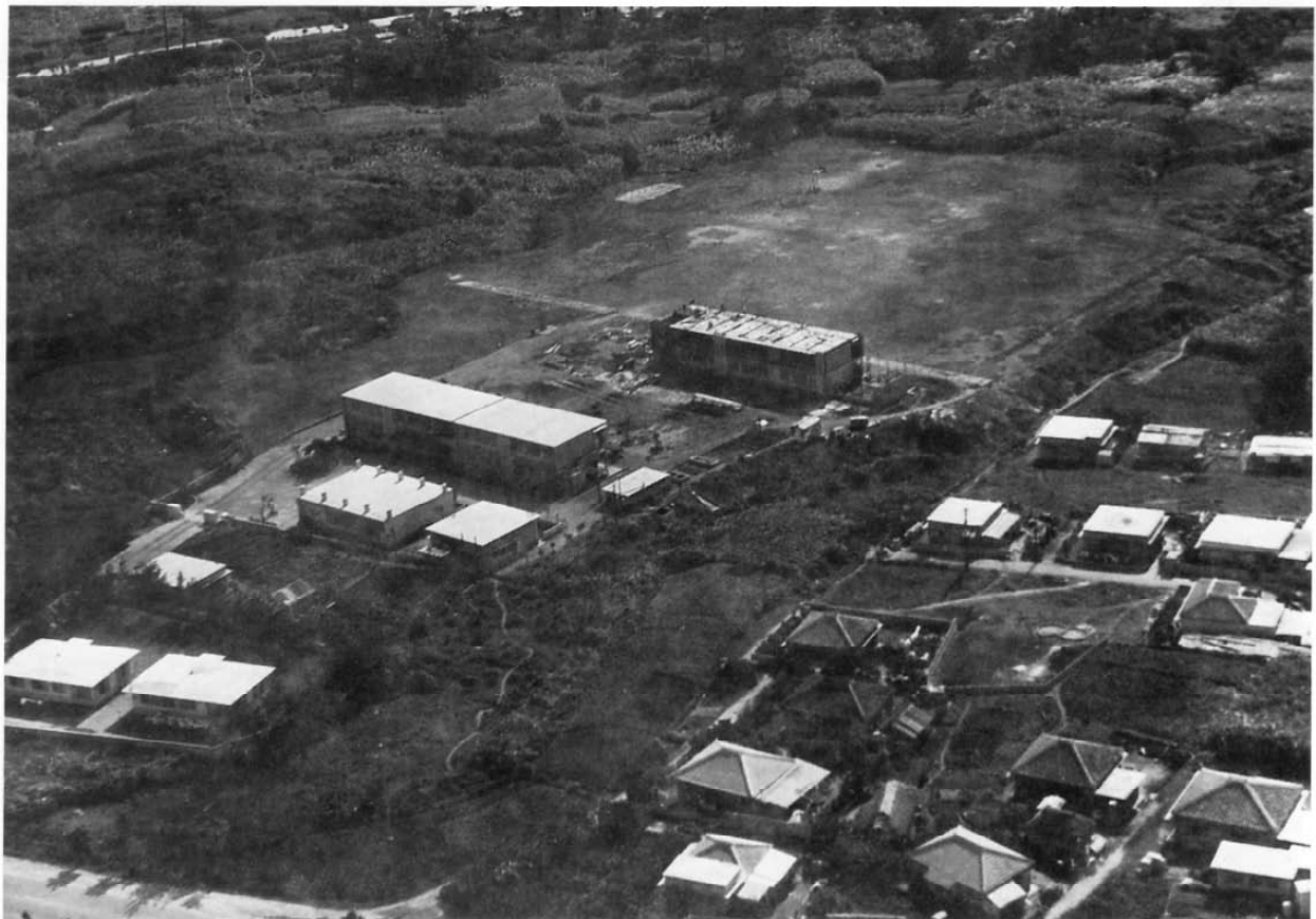
249 古堅中学校が伊良皆に新築移転した。1964年（昭和39）。
