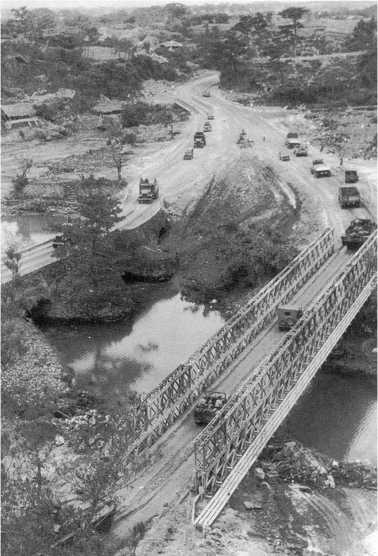
ここ比謝橋では、比謝橋破壊の任務をおった中村1個中隊と米軍との間で、読谷村で唯一戦闘らしい戦闘が行なわれた。以後、旧来の石橋は修復され、さらに4月には屋良より鉄橋を架設し、前線への物資補給に供した。(6月)
