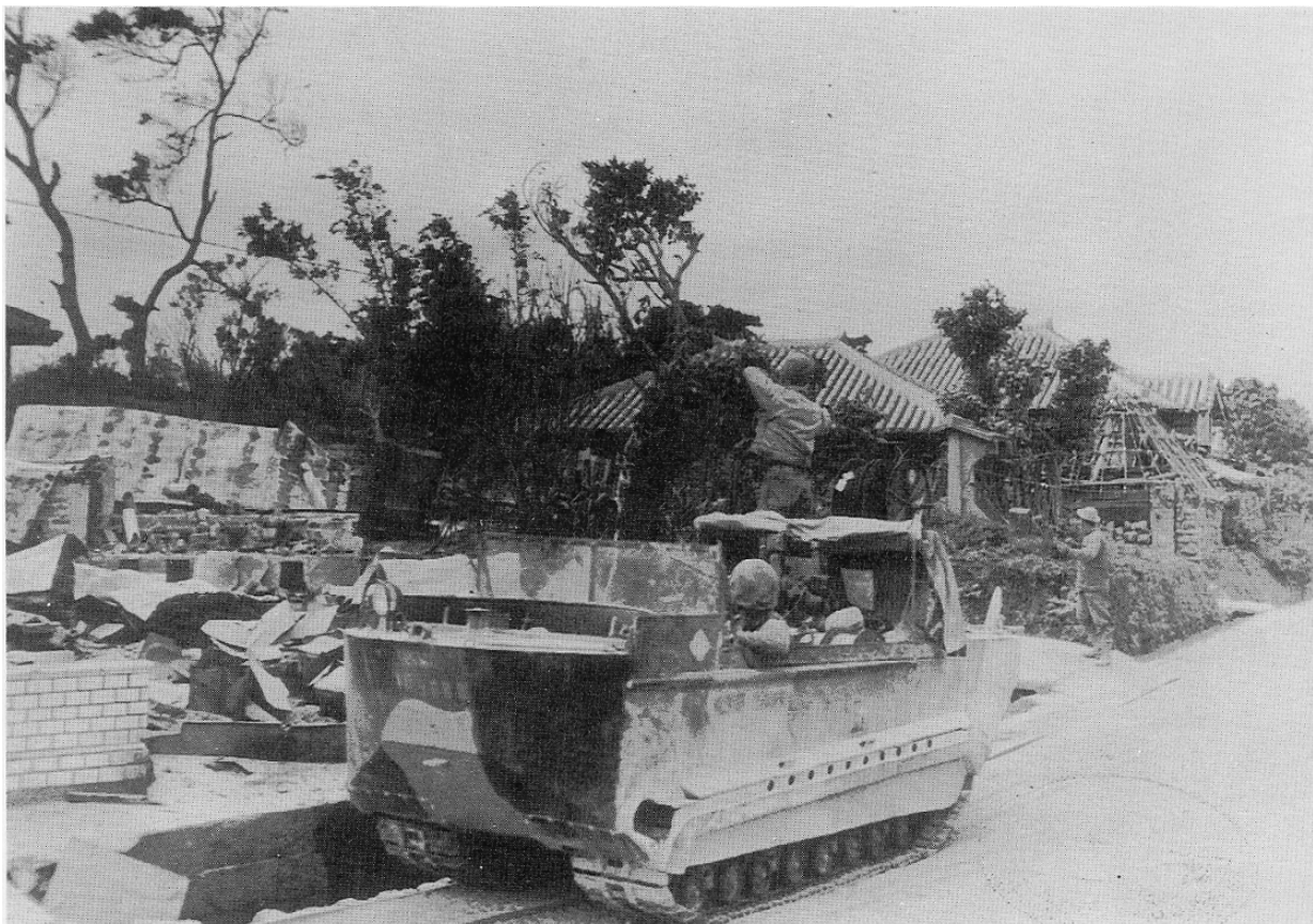
上陸後、前線の後方になった読谷村では電話線架設が開始された。作業にあたる万能改造車。（場所不明）
