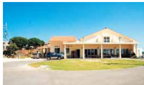
2005年6月完成 座喜味公民館
