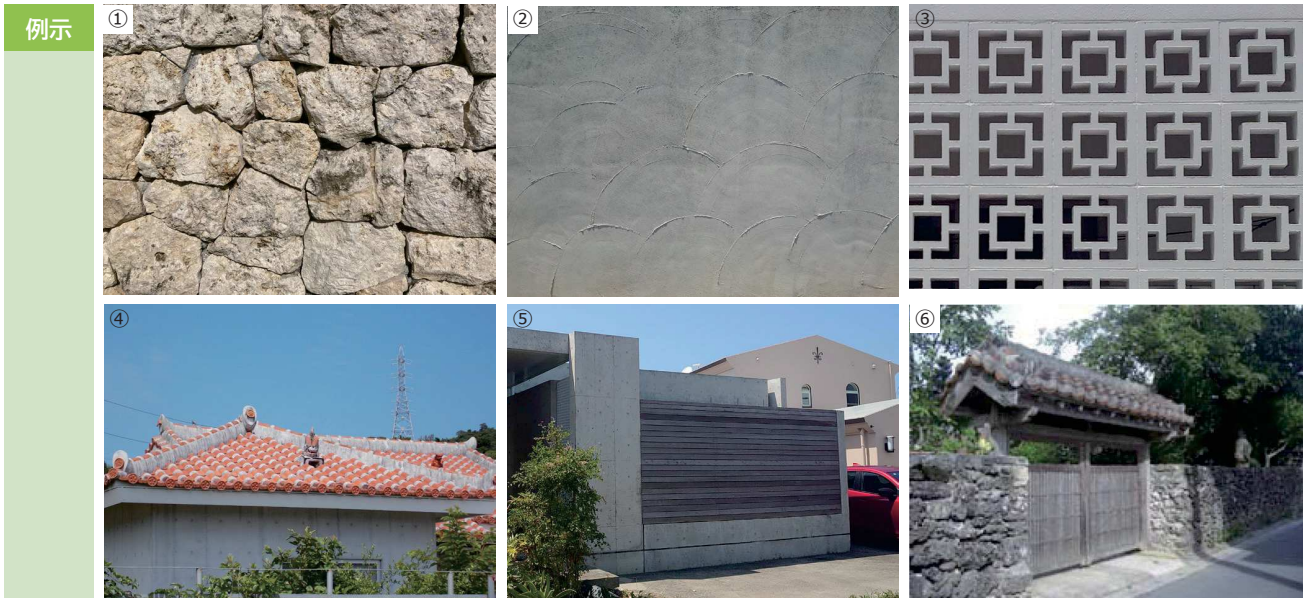
①琉球石灰岩 ②漆喰 ③花ブロック ④赤瓦 ⑤木材の素材の例。 ⑥素焼赤瓦、漆喰、木製の門、石垣が時間の経過により、落ち着いた雰囲気を出している例。 ※⑥の出典は「沖縄県景観形成ガイドライン」
