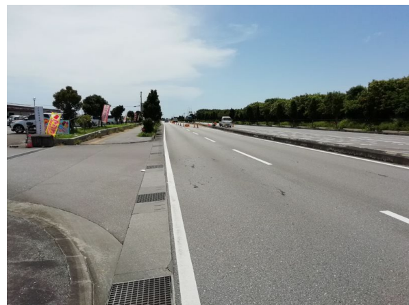
村道中央残波線（ファーマーズマーケット前）
