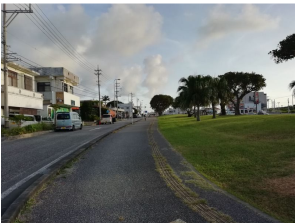
国道58号（大湾付近の左側の通行帯）
