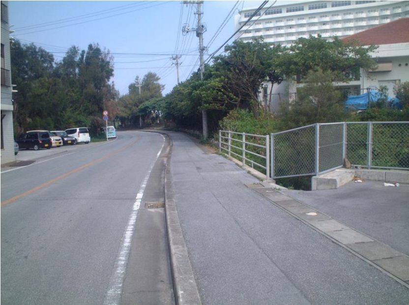
ワタベ付近給水立上管 宇座659-1
