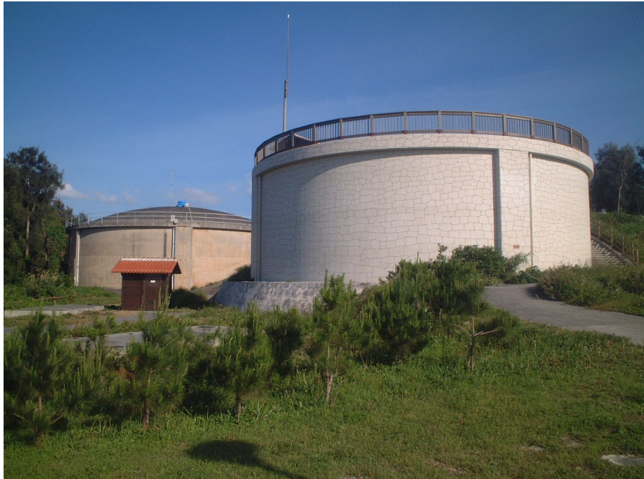
座喜味城跡配水池・座喜味第2配水池
