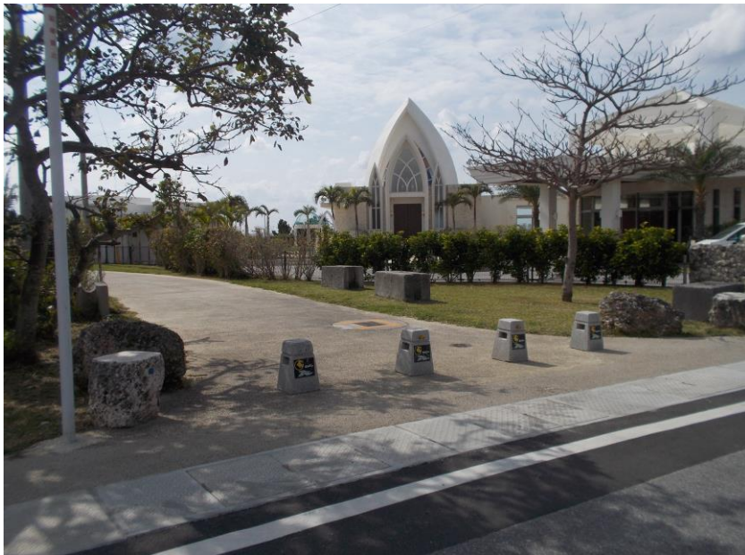
ワタベ付近消火栓 宇座659-3
