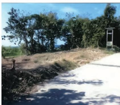
海への流出を防止するため、草木の伐採と土砂の撤去作業
