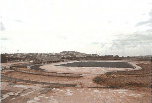
▲工事中の陸上競技場
