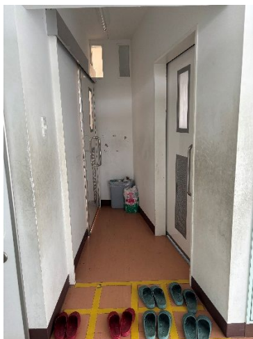
多目的トイレが改修によって設置されたため、非常に狭いトイレの入り口となっている。
