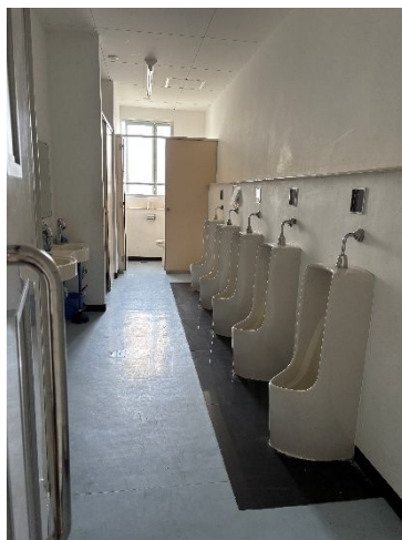
現在の校舎のトイレは、乾式（ビニル床シート）仕上の仕様となっている。
