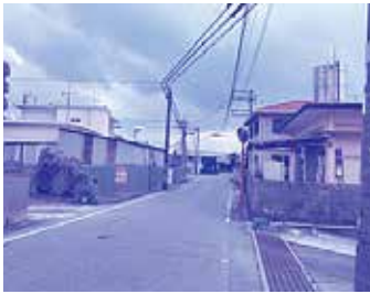
村道大木・比謝線と国道58号交差点 手前の2本の電柱
