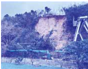
台風6号長時間により崖区連れが発生した楚辺・ミサワ会地域
