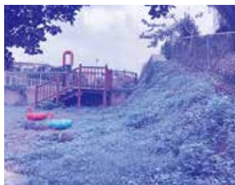
比謝公園内の法面
