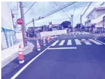
渡慶次小学校横の交差点整備完了後
