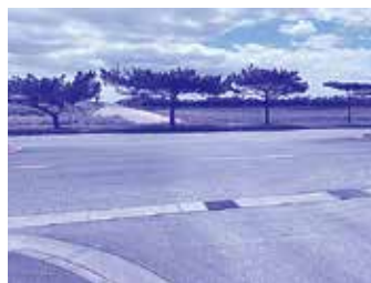
令和6年度交差点改修工事施工 予定の中央残波線大木喜名線交差点
