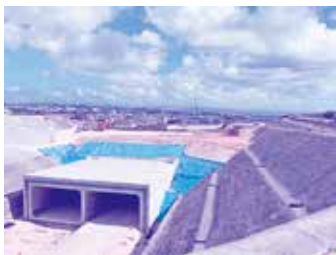
進捗中の沖縄西海岸道路 「国道58号読谷道路」
