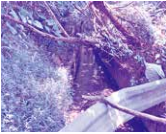
イーヌカー上流のコンクリート排水路
