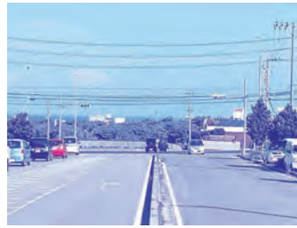
村道中央残波線の北伸整備事業
