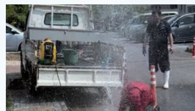
漏水対応・修繕
