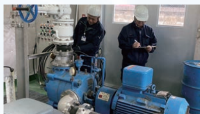
施設の点検・維持管理
