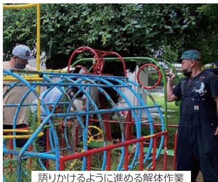
語りかけるように進める解体作業
