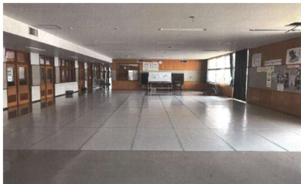
①間仕切り設置前
