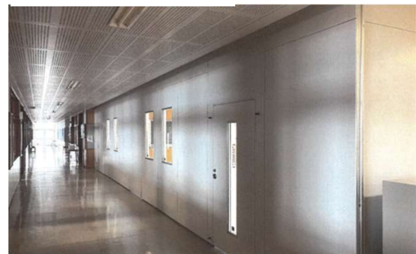
④間仕切り設置後(3)
