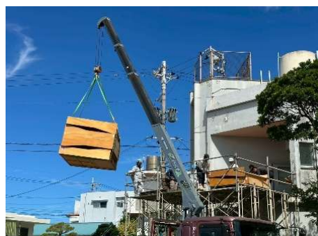
▲クレーンを用いて2Fから廃品搬出
