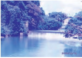
今年度から解体工事に入る比謝川下流堰
