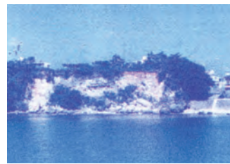
令和4年度より崖崩れ対策工事が予定されている
