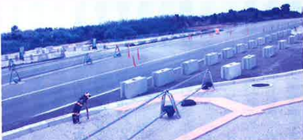
村道中央残波線の交差点改良工事
