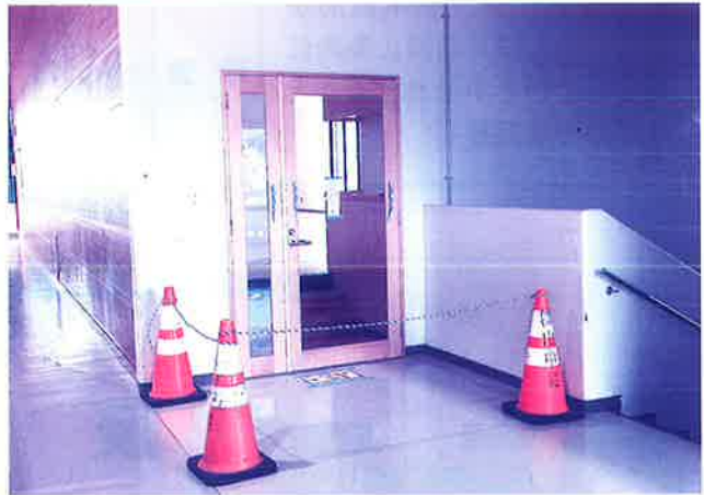
読谷小学校体育館2階、建設中の学童保育
