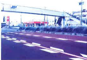
国道58号線中央分離帯の雑草繁茂状況
