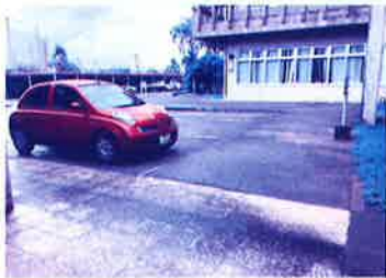
身障者駐車場 雨天時に滑りやすい歩行路
