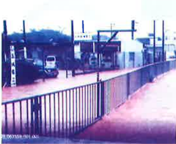
玉城電工前の排水路（大湾1号線）
