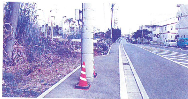
歩道中央に設置された電柱
