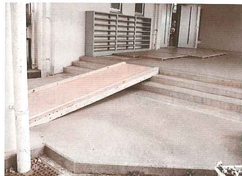
特別支援教育の一端としてスロープが設置された(古堅小学校体育館玄関前)
