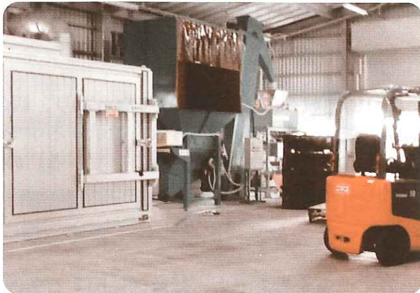
バイオマス試験研究施設
