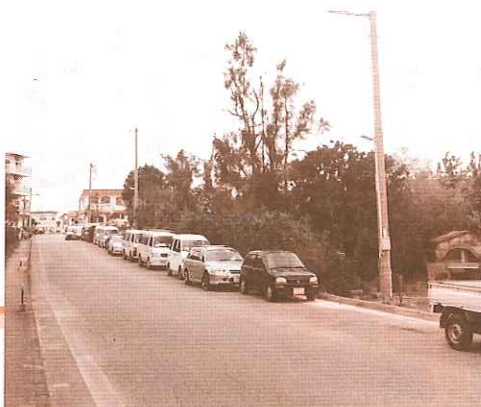
地盤沈下する横田地区入口の墓地
