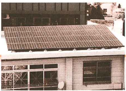
太陽光システムを設置した住宅
