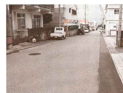
整備が進んでいる配水溝(楚辺区内)
