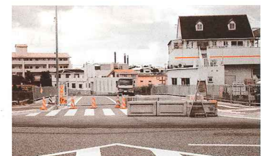
近日供用開始予定村道伊良皆南線
