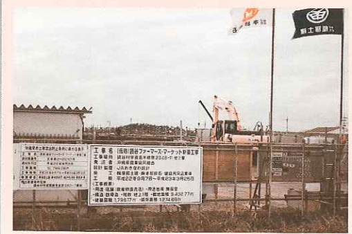
建設中の読谷ファーマーズマーケット
