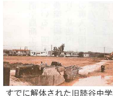
すでに解体された旧読谷中学校跡
