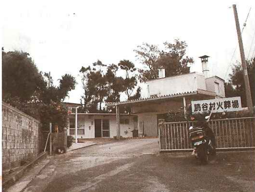
老朽化の進む読谷火葬場
