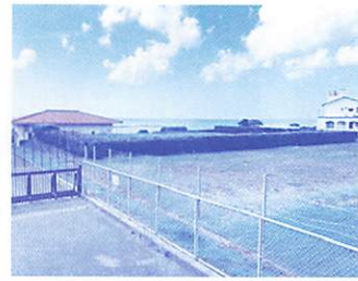
楚辺浄化センター
