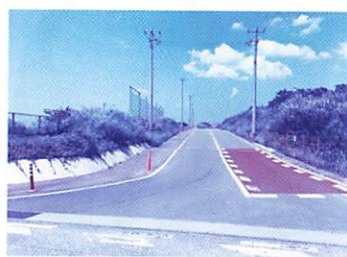
防犯灯未整備（伊良皆地区）
