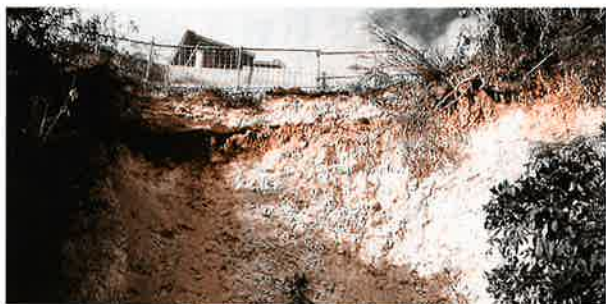
崖の崩落状況
