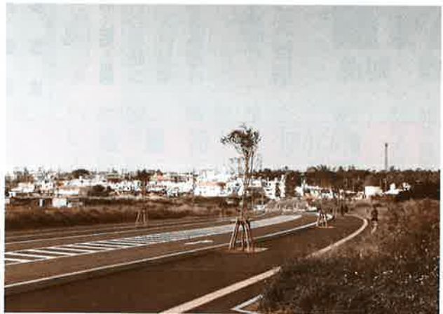
村道楚辺座喜味線整備工事
