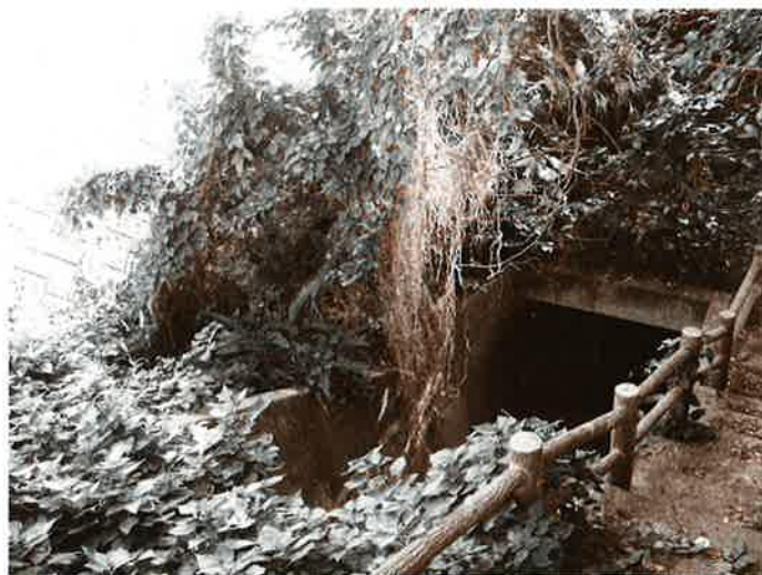
比謝団地近くの排水路
