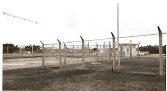
トリイメインゲートの移設建設計画がされている大木ゲート
