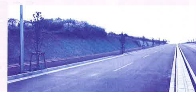
中央残波線沿いの、のり面
