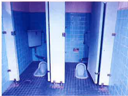
農村運動広場のトイレ（現状）
