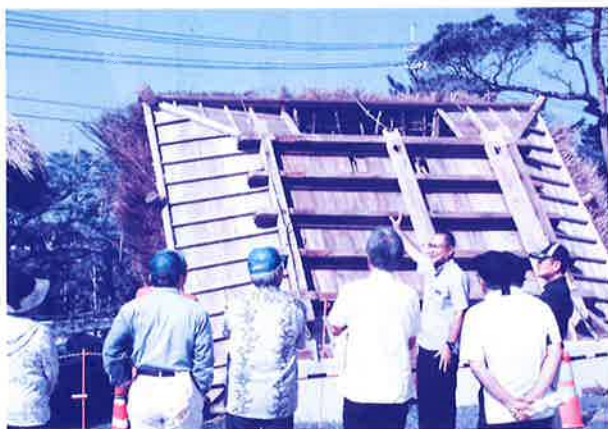
台風により倒壊した高倉(座喜味城跡)
