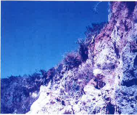
泊城公園の崖崩れ防止対策が急がれる
