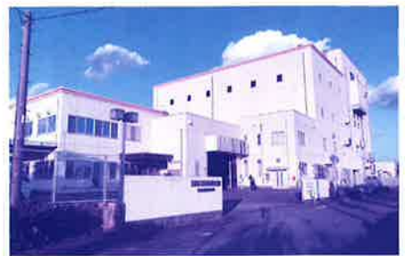
老朽化が進む環境美化センター
