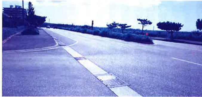
信号機がなく危険な交差点
