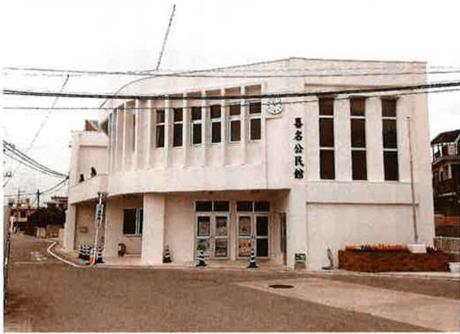
喜名地区学習等供用施設
