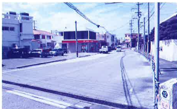
なかなか進まない県道12号線の工事状況
