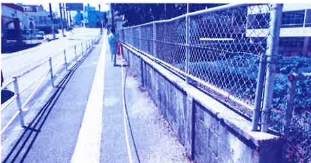
改修前のブロック塀
