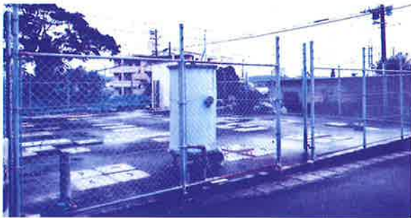
地盤沈下が深刻なニュータウンの浄化槽
