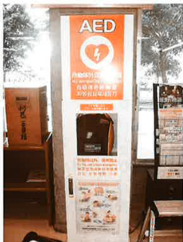
各字公民館へAED設置
