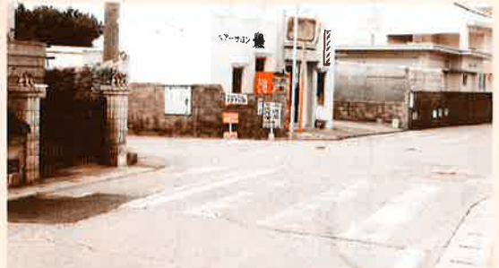
横田自治会（ハイランド）入口の補修必要な道路
