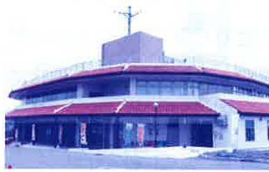
完成した地域振興センター
