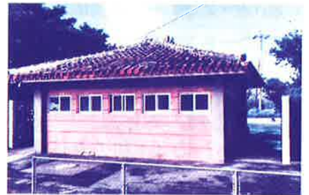
悪臭がひどい駐車場トイレ
