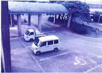
障がい者駐車場に早急に屋根設置を！
